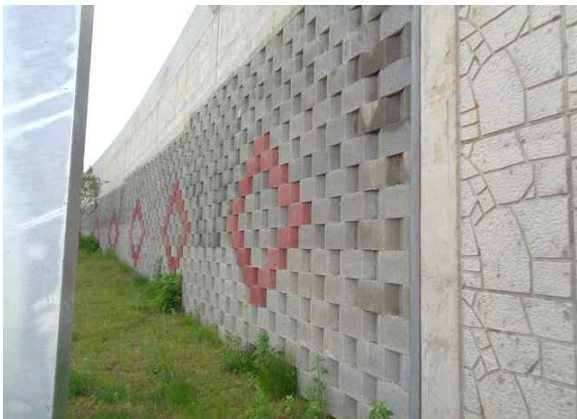
1공구 보강토옹벽(본선 휴게소통과교량)
