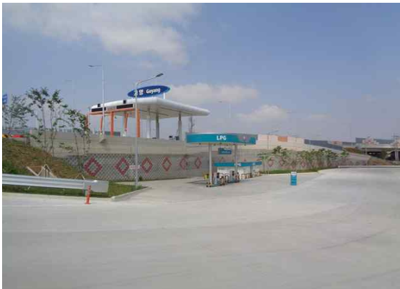
1공구 보강토옹벽(본선 STA.4+993~5+110)
