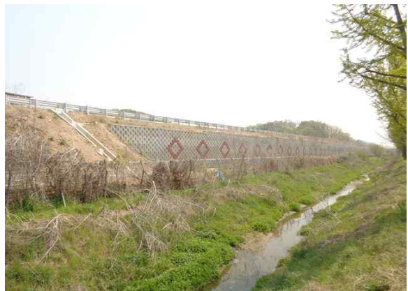
1공구 보강토옹벽(지선 STA.0+321~0.680)
