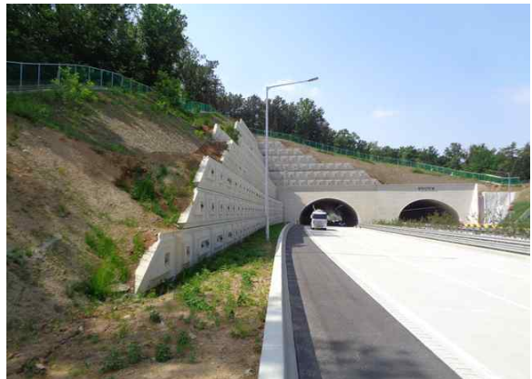
1공구 보강토옹벽(본선 STA.6+933~7+040)
