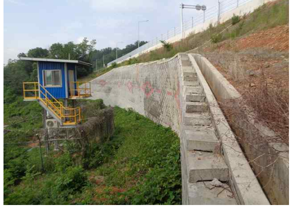
1공구 보강토옹벽(본선 STA.1+914~2+020)
