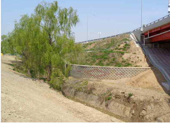
1공구 보강토옹벽(본선 STA.0+283~0+400)
